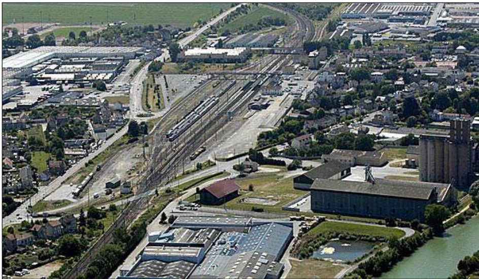
La gare de triage de Château-Thierry aujourd'hui. Seuls les alentours ont quelque peu changé depuis 1944. Sandy et ses équipiers l'attaquèrent par des passes de mitrailleuse Nord-Sud, c'est à dire de droite à gauche.
